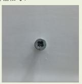
2. 将声光报警器背部的槽(下图红色圈圈)挂在螺丝头上。
